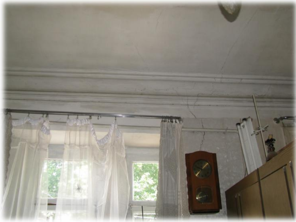
სპრ. №38 სპრ. №35, ინგერიერი“А” ბლოკი. II - III სართულის დაზიანებული კედლები, ბზარი კედელზე (2-5 მმ).
