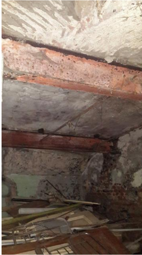
სურ. №54 სარდაფის სართული. დაზიანებული აგურის თაღის გადახურვის კონსტრუქცია, რომელიც გაძლიერებულია მეტალის ორგესებრი კოჭებით;
