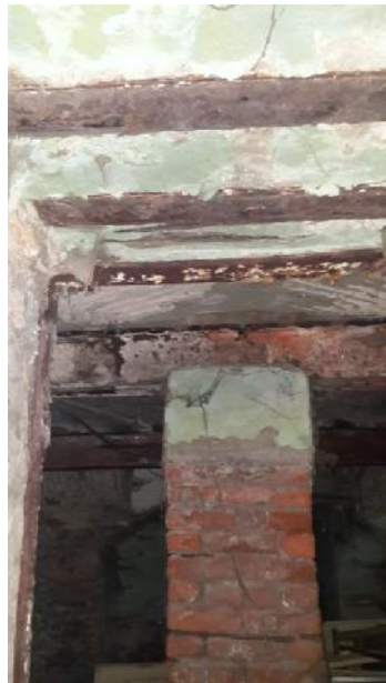
სურ. №55 სარდაფის სართული. გამოუყენებელია. დაზიანებული აგურის თაღის სამაგრი ლითონის კონსტრუქცია დაყრდნობილი აგურის წყობის ღვარზე;
