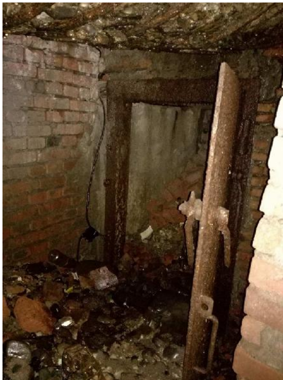
სურ. №50 სარდაფის სართული. დასველებულია, დეფორმირებულია და ავარიულ მდგომარეობაშია გადახურვის რკ/ბ-ის და მეგალის კონსტრუქციები.
