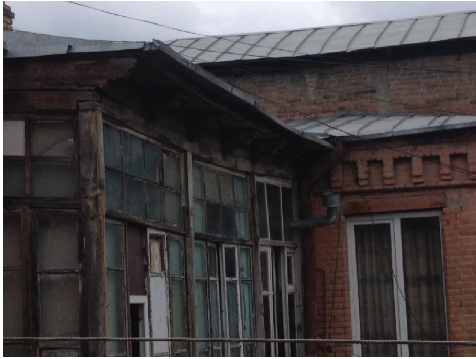
სპრ. №62 “C” ბლოკი. დეფორმირებული და დაზიანებული ხის კონსტრუქციის შუშაბანდი.
