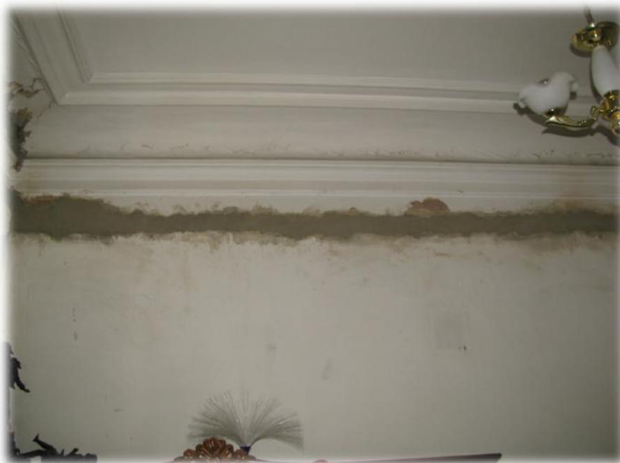
სპრ. №36, ინგერიერი“А” ბლოკი. II - III სართულის დაზიანებული კედლები, ბზარები ახალი ამოვსებულია ქვიშა-ცემენტის ხსნარით.
