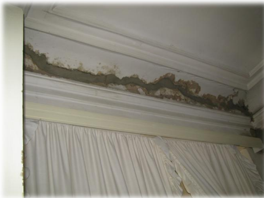
სპრ. №37, ინგერიერი“А” ბლოკი. II - III სართულის დაზიანებული კედლები, ბზარები ახალი ამოვსებულია ქვიშა-ცემენტის ხსნარით.
