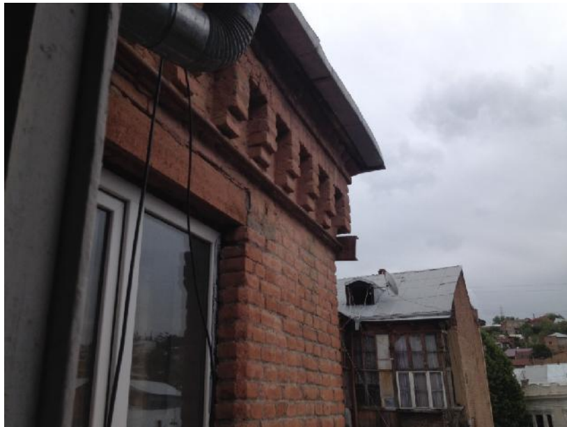
სპრ. №63 “C” ბლოკი. ადრე შესრულებული ღიობის გაძლიერება და კედლის მოჭიმვა მეტალის ჭიმით.
