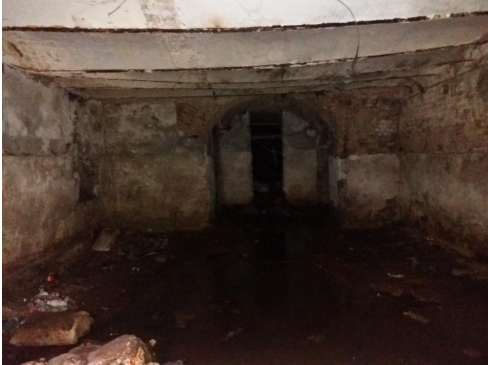
სურ. №44 სარდაფის სართულის ხედი სარდაფში დგას წყალი, დეფორმირებულია და კოროზირებულია გადახურვის კოჭები
