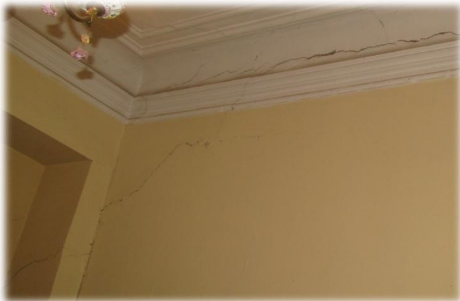
სპრ. №39, ინგერიერი“А” ბლოკი. II - III სართულის დაზიანებული კედლები, ბზარი კედელზე (3-6 მმ).
