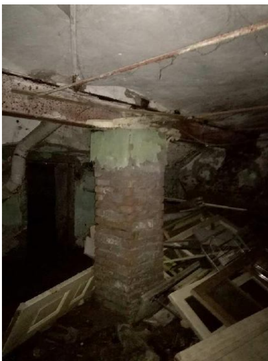
სურ. №51 სარდაფის სართული. დაზიანებულ აგურის თაღური გადახურვის ქვეშ მოწყობილი მეგალის კოროზირებული კოჭი დაყრდნობილია ღრობებით აგურის წყობის ღვარზე;
